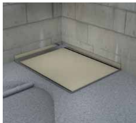
GETTATA MASSETTO SOTTOFONDO - THROWN SCREED JETÉ DE CHAPES - LANZADO DE SOLADO ESTRICH LEGEN - Укладка стяжки
